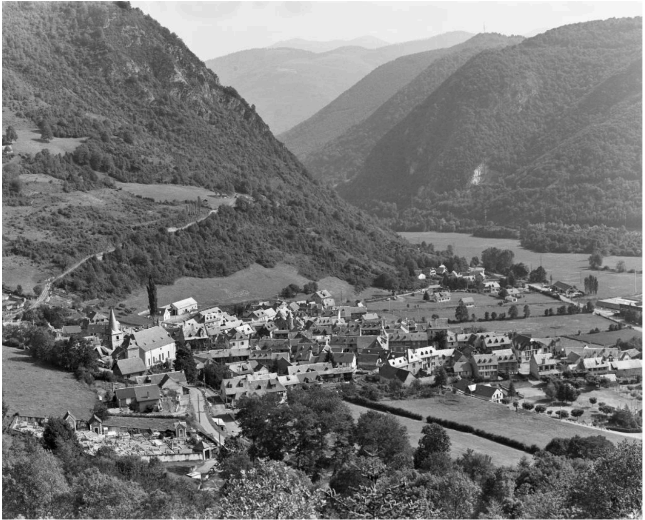
Vue d'ensemble depuis les hauteurs voisines.
