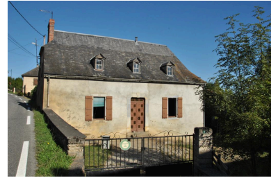
Vue de l'élévation principale depuis l'est. Phot. Marion Fourcayran IVD65_20146500442NUCA
