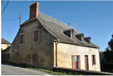
Vue du logis depuis le sud-est. Phot. Marion Fourcayran IVD65_20146500443NUCA
