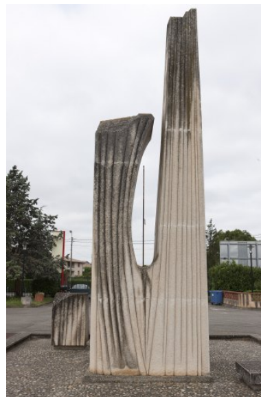
Vue d'ensemble de l'élément 2 depuis le lycée. Phot. Philippe Poitou IVR73_20113154504NUCA
