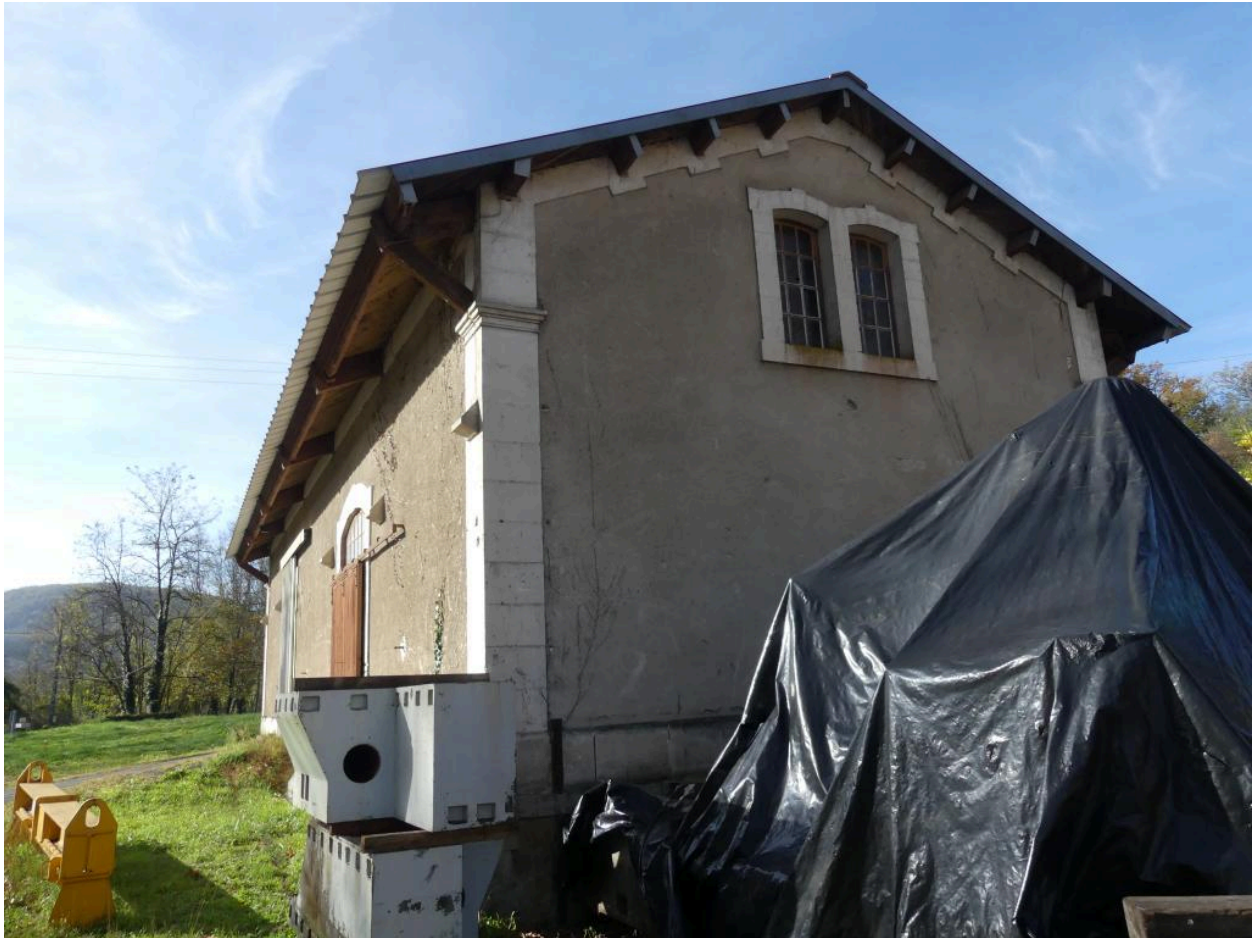
Halles à marchandises : vue du pignon nord-est.
