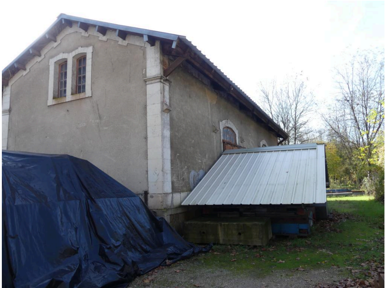
Halles à marchandises : pignon nord-est et façade nord-ouest.
