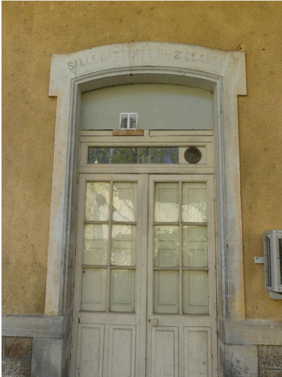
Bâtiment des voyageurs, côté voie ferrée : porte de la dernière travée à droite.
