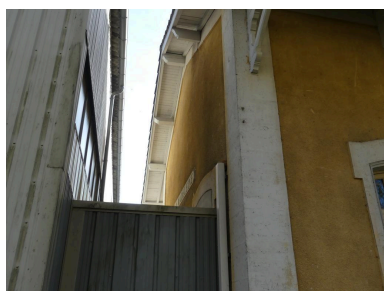
Bâtiment des voyageurs, côté voie ferrée : aperçu du pignon nord-est.. Phot. Guillaume Bernard, Phot. Fabien Cadot IVD46_20214605595NUCA
