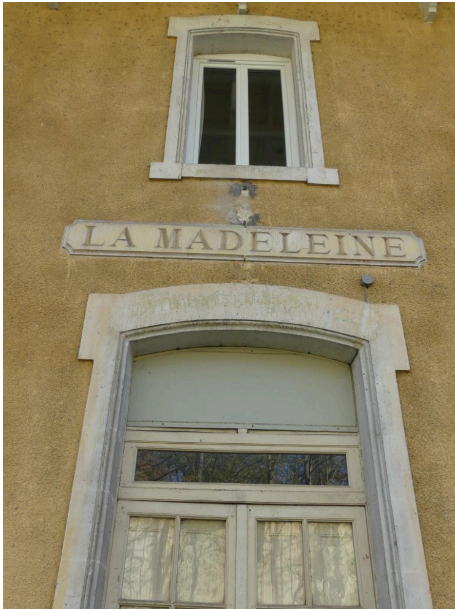
Bâtiment des voyageurs, côté voie ferrée : travée centrale.
