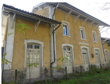
Bâtiment des voyageurs : élévation côté voie ferrée, au nord. Phot. Guillaume Bernard, Phot. Fabien Cadot IVD46_20214605588NUCA
