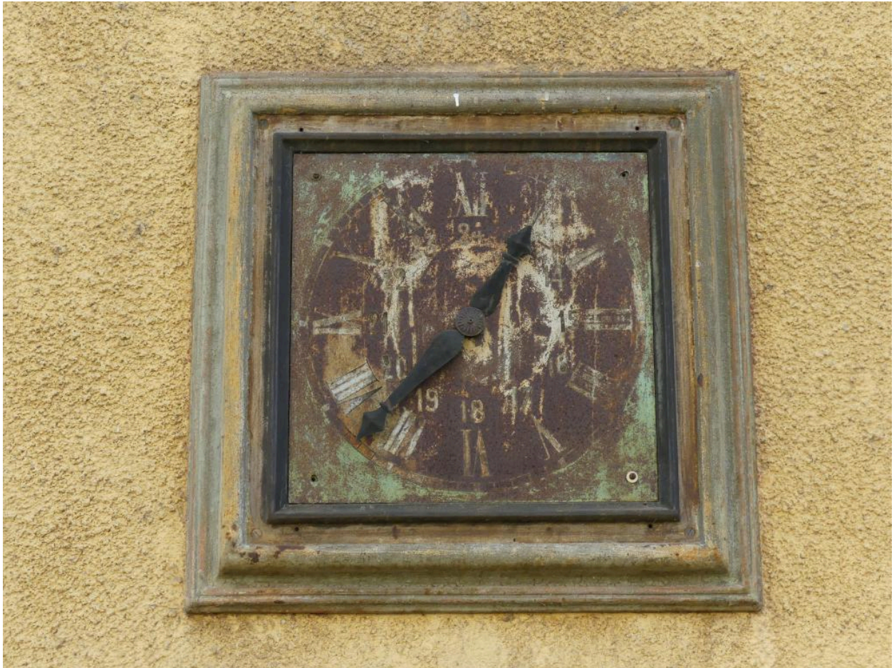
Bâtiment des voyageurs, côté voie ferrée : horloge.
