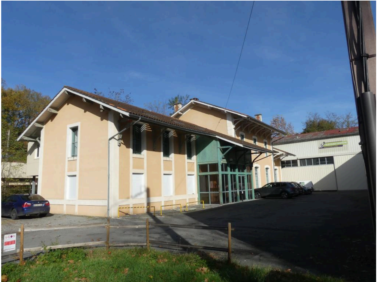
Bâtiment des voyageurs : vue depuis le sud-ouest, côté cour.
