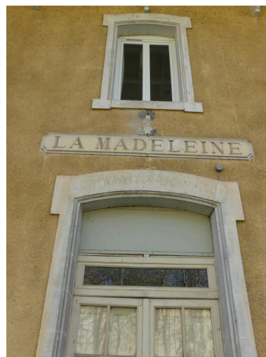
Bâtiment des voyageurs, côté voie ferrée : travée centrale. Phot. Guillaume Bernard, Phot. Fabien Cadot IVD46_20214605583NUCA
