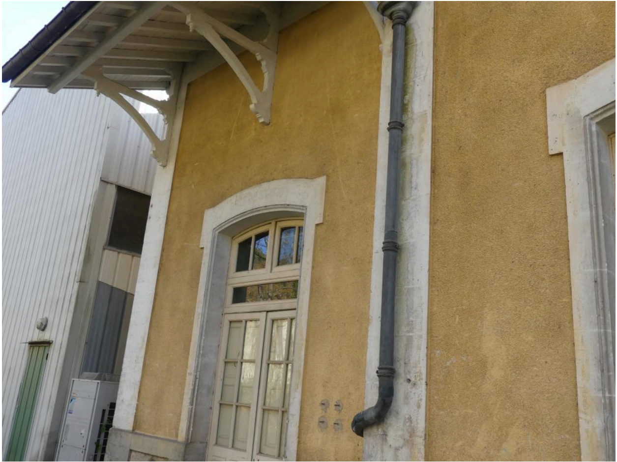
Bâtiment des voyageurs, côté voie ferrée : travée nord-est.
