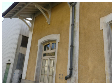
Bâtiment des voyageurs, côté voie ferrée : travée nord-est. Phot. Guillaume Bernard, Phot. Fabien Cadot IVD46_20214605596NUCA
