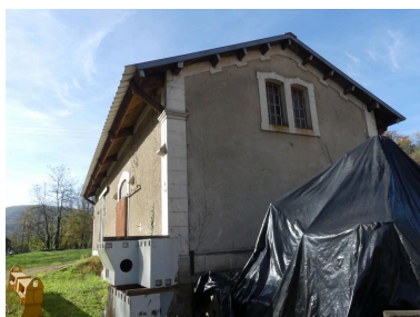
Halles à marchandises : vue du pignon nord-est. Phot. Guillaume Bernard, Phot. Fabien Cadot IVD46_20214605597NUCA
