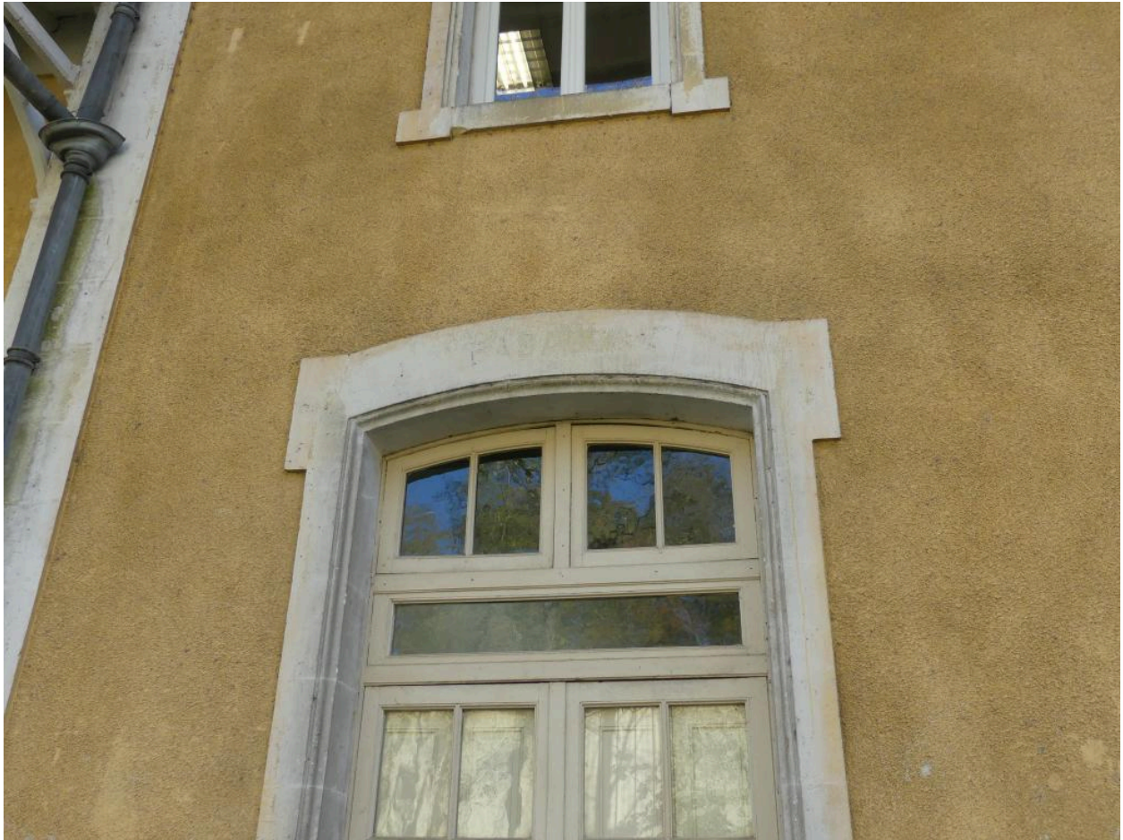
Bâtiment des voyageurs, côté voie ferrée : détail façade du corps central.
