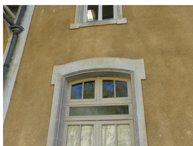
Bâtiment des voyageurs, côté voie ferrée : détail façade du corps central. Phot. Guillaume Bernard, Phot. Fabien Cadot IVD46_20214605590NUCA
