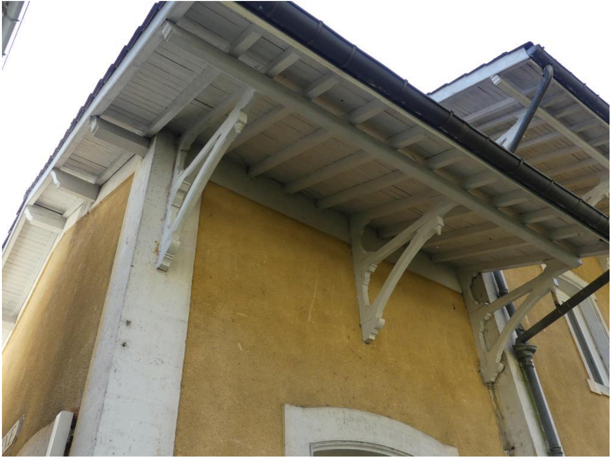
Bâtiment des voyageurs, côté voie ferrée : débord de toiture de la partie nord-est.
