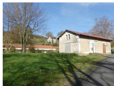
Halles à marchandises : vue depuis le sud. Phot. Guillaume Bernard, Phot. Fabien Cadot IVD46_20214605586NUCA
