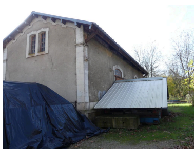
Halles à marchandises : pignon nord-est et façade nord-ouest. Phot. Guillaume Bernard, Phot. Fabien Cadot IVD46_20214605593NUCA
