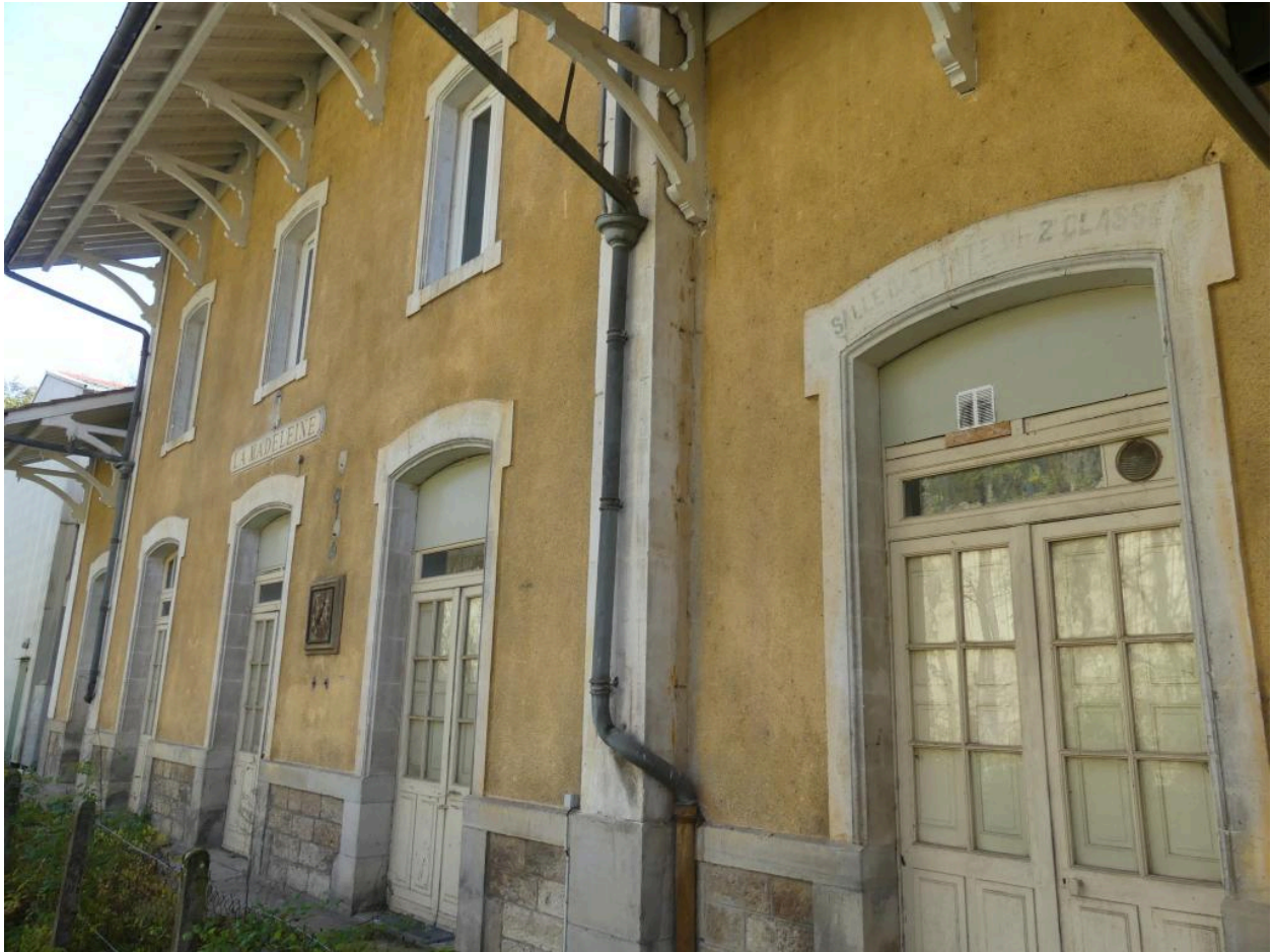
Bâtiment des voyageurs, côté voie ferrée : vue de la façade depuis l'ouest.
