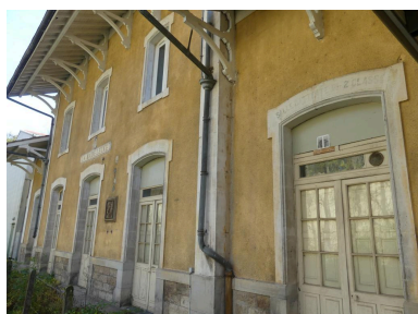
Bâtiment des voyageurs, côté voie ferrée : vue de la façade depuis l'ouest. Phot. Guillaume Bernard, Phot. Fabien Cadot IVD46_20214605594NUCA
