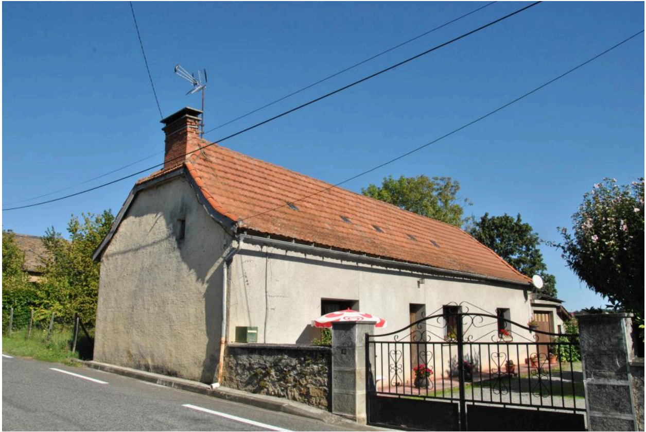
Vue de l'élévation principale depuis l'est.
