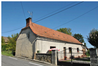
Vue de l'élévation principale depuis l'est.
