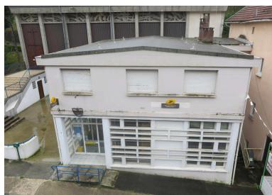
Vue de la façade de la poste depuis le boulevard des Pyrénées. Phot. Alice de la Taille IVR76_20206506004NUCA
