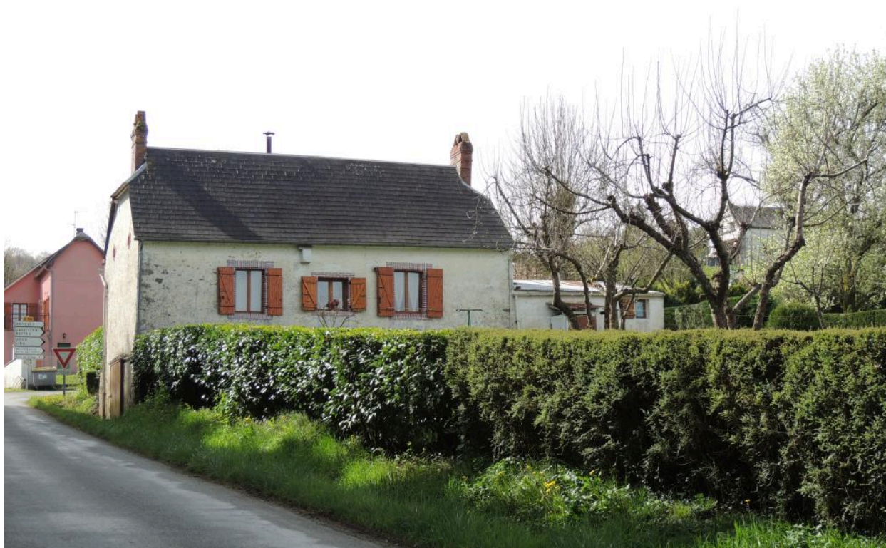
Vue de l'élévation nord.
