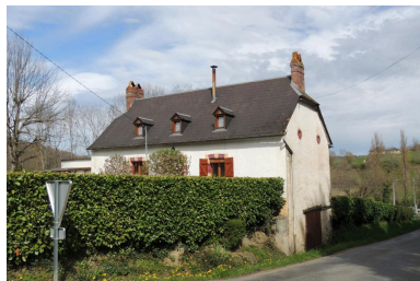
Vue de l'élévation principale depuis le sud-est. Phot. Marion Fourcayran IVD65_20136500133NUCA
