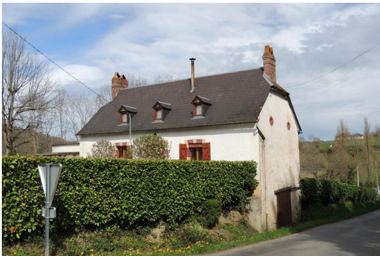
Vue de l'élévation principale depuis le sud-est.
