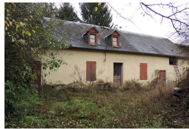
Vue de l'élévation principale depuis le sud. Phot. Marion Fourcayran IVD65_20136500053NUCA
