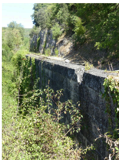
Mur de soutènement (M12). Phot. Fabien Cadot IVD46_20244600074NUCA
