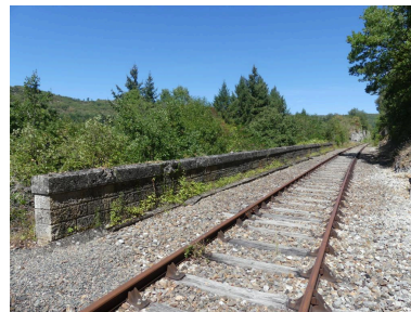
Mur de soutènement (M12). Phot. Fabien Cadot IVD46_20244600073NUCA
