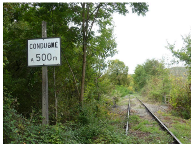
Panneau de signalisation, à 500 m de la gare de Conduché. Phot. Fabien Cadot IVD46_20244600067NUCA
