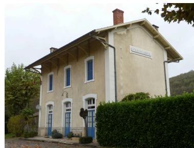
Bâtiment des voyageurs, vue depuis le sud-est. Phot. Guillaume Bernard, Phot. Fabien Cadot IVD46_20214605015NUCA
