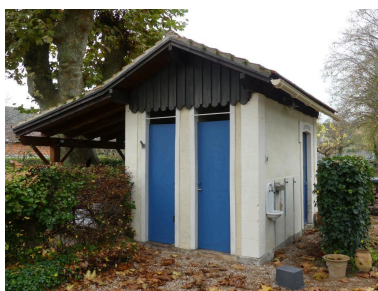
Toilettes et lampisterie, pignon sud-est : porte des toilettes. Phot. Guillaume Bernard, Phot. Fabien Cadot IVD46_20214605007NUCA
