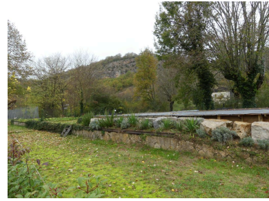
Vestiges de la rampe des halles à marchandises disparues. Phot. Guillaume Bernard, Phot. Fabien Cadot IVD46_20214605004NUCA
