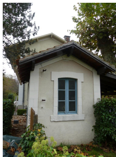
Toilettes et lampisterie, élévation nord-ouest. Phot. Guillaume Bernard, Phot. Fabien Cadot IVD46_20214605018NUCA
