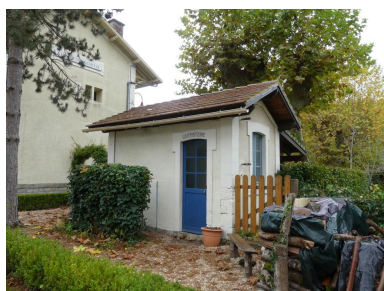
Toilettes et lampisterie, vue depuis le nord. Phot. Guillaume Bernard, Phot. Fabien Cadot IVD46_20214605006NUCA
