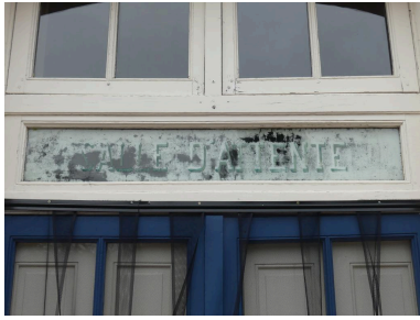
Bâtiment des voyageurs, élévation nord-est : cartouche indiquant l'accès à la salle d'attente. Phot. Guillaume Bernard, Phot. Fabien Cadot IVD46_20214605019NUCA
