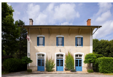
Elévation sur cour. Phot. Amélie Boyer IVR76_20244650184NUCA
