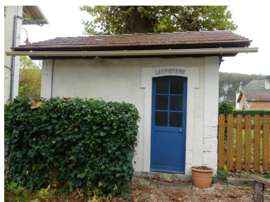
Toilettes et lampisterie, élévation nord-est. Phot. Guillaume Bernard, Phot. Fabien Cadot IVD46_20214605008NUCA
