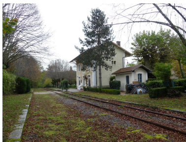
Vue depuis le nord-ouest. Phot. Guillaume Bernard, Phot. Fabien Cadot IVD46_20214605021NUCA
