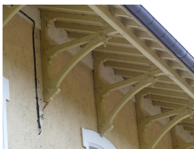
Bâtiment des voyageurs, élévation sud-ouest : aisseillers. Phot. Guillaume Bernard, Phot. Fabien Cadot IVD46_20214605014NUCA
