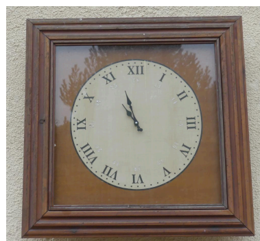
Bâtiment des voyageurs, élévation nord-est : horloge murale. Phot. Guillaume Bernard, Phot. Fabien Cadot IVD46_20214605011NUCA
