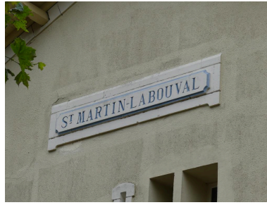
Bâtiment des voyageurs, élévation nord-ouest : cartouche contenant le nom de la station. Phot. Guillaume Bernard, Phot. Fabien Cadot IVD46_20214605009NUCA
