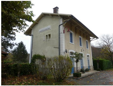
Bâtiment des voyageurs, vue depuis l'ouest. Phot. Guillaume Bernard, Phot. Fabien Cadot IVD46_20214605010NUCA
