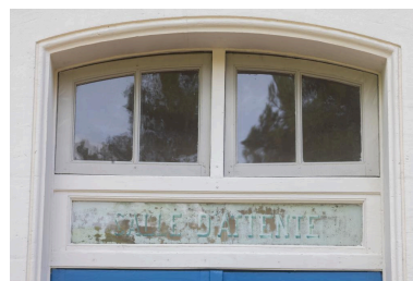
Elévation sur la voie : imposte d'une porte. Phot. Amélie Boyer IVR76_20244650191NUCA
