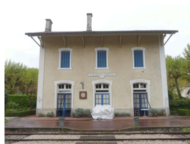
Bâtiment des voyageurs, élévation nord-est. Phot. Guillaume Bernard, Phot. Fabien Cadot IVD46_20214605012NUCA
