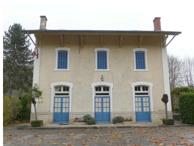
Bâtiment des voyageurs, élévation sud-ouest. Phot. Guillaume Bernard, Phot. Fabien Cadot IVD46_20214605017NUCA
