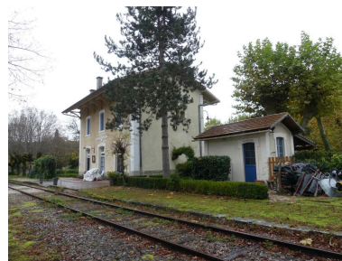
Vue depuis le nord-ouest. Phot. Guillaume Bernard, Phot. Fabien Cadot IVD46_20214605016NUCA
