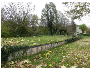
Vestiges de la rampe des halles à marchandises disparues. Phot. Guillaume Bernard, Phot. Fabien Cadot IVD46_20214605020NUCA
