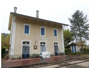
Bâtiment des voyageurs, élévation nord-est. Phot. Guillaume Bernard, Phot. Fabien Cadot IVD46_20214605013NUCA
