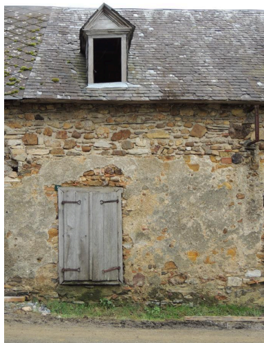
Détail de la façade sur rue (fenêtre et lucarne). Phot. Marion Fourcayran IVD65_20146500459NUCA
