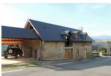
Vue de la ferme en cours de réhabilitation. Phot. Marion Fourcayran IVD65_20146500464NUCA
