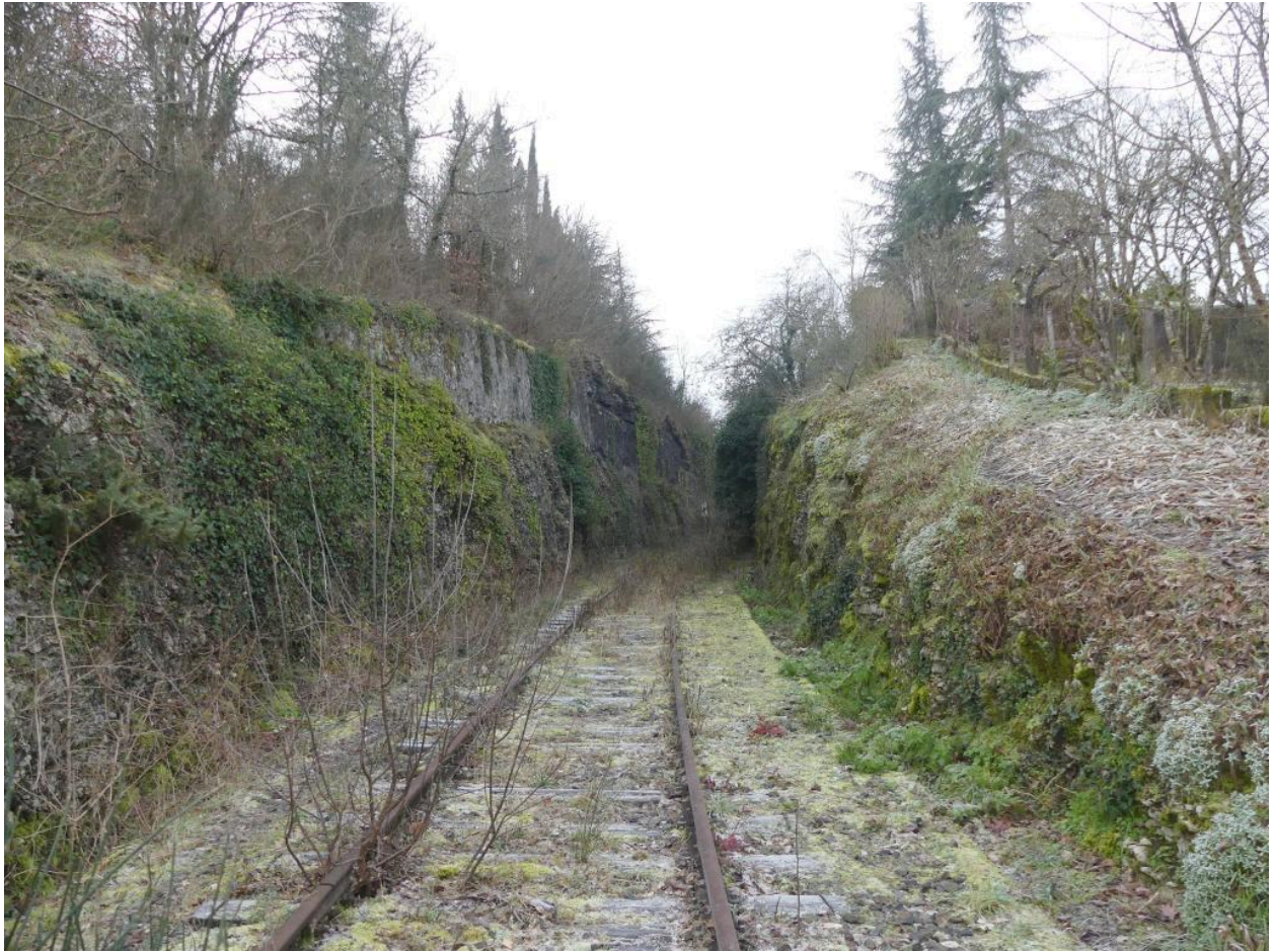
Vue de la voie, près du tunnel Saint-Georges.
