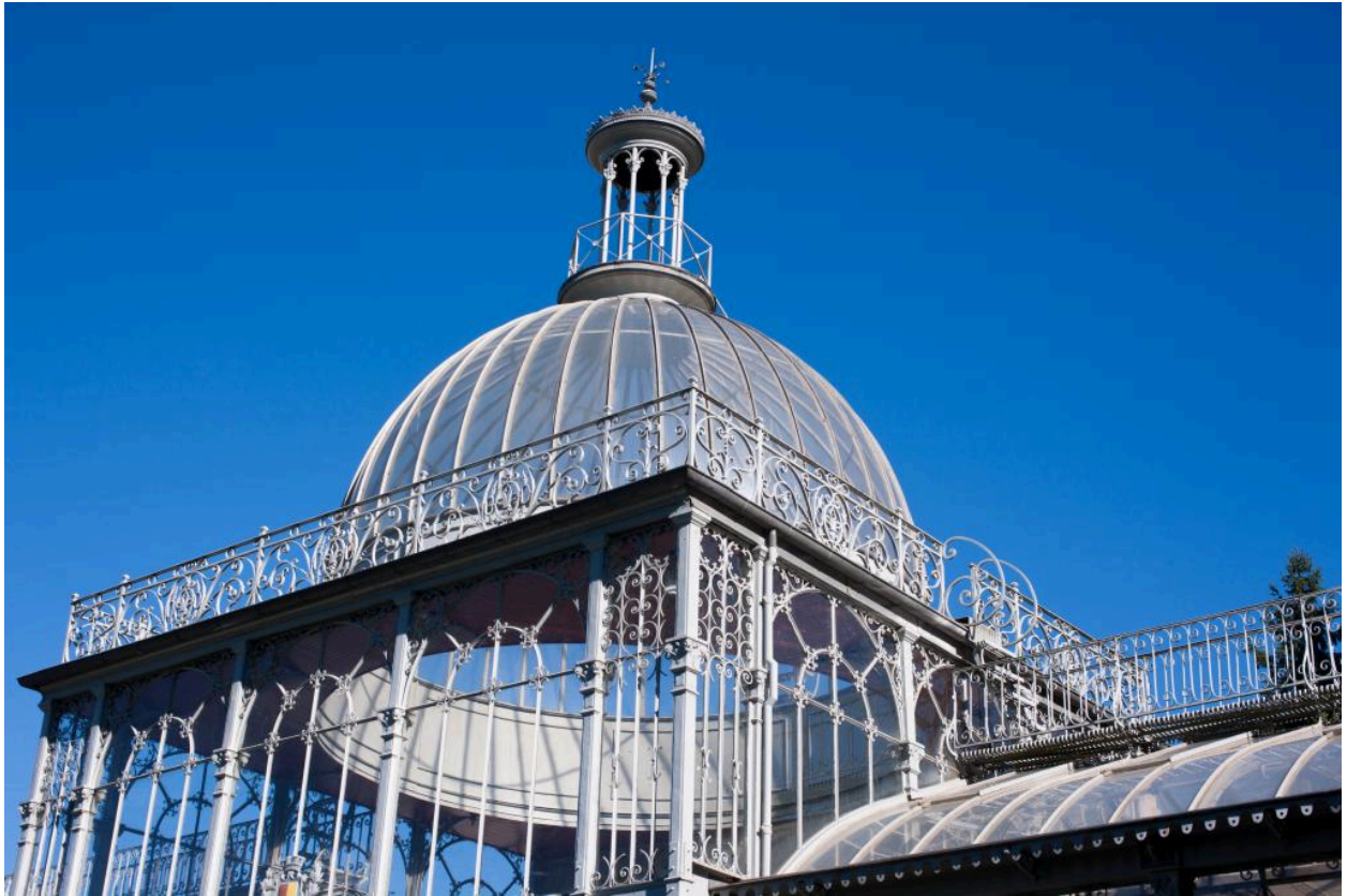
La coupole vitrée au-dessus du vestibule central : vue extérieure.
