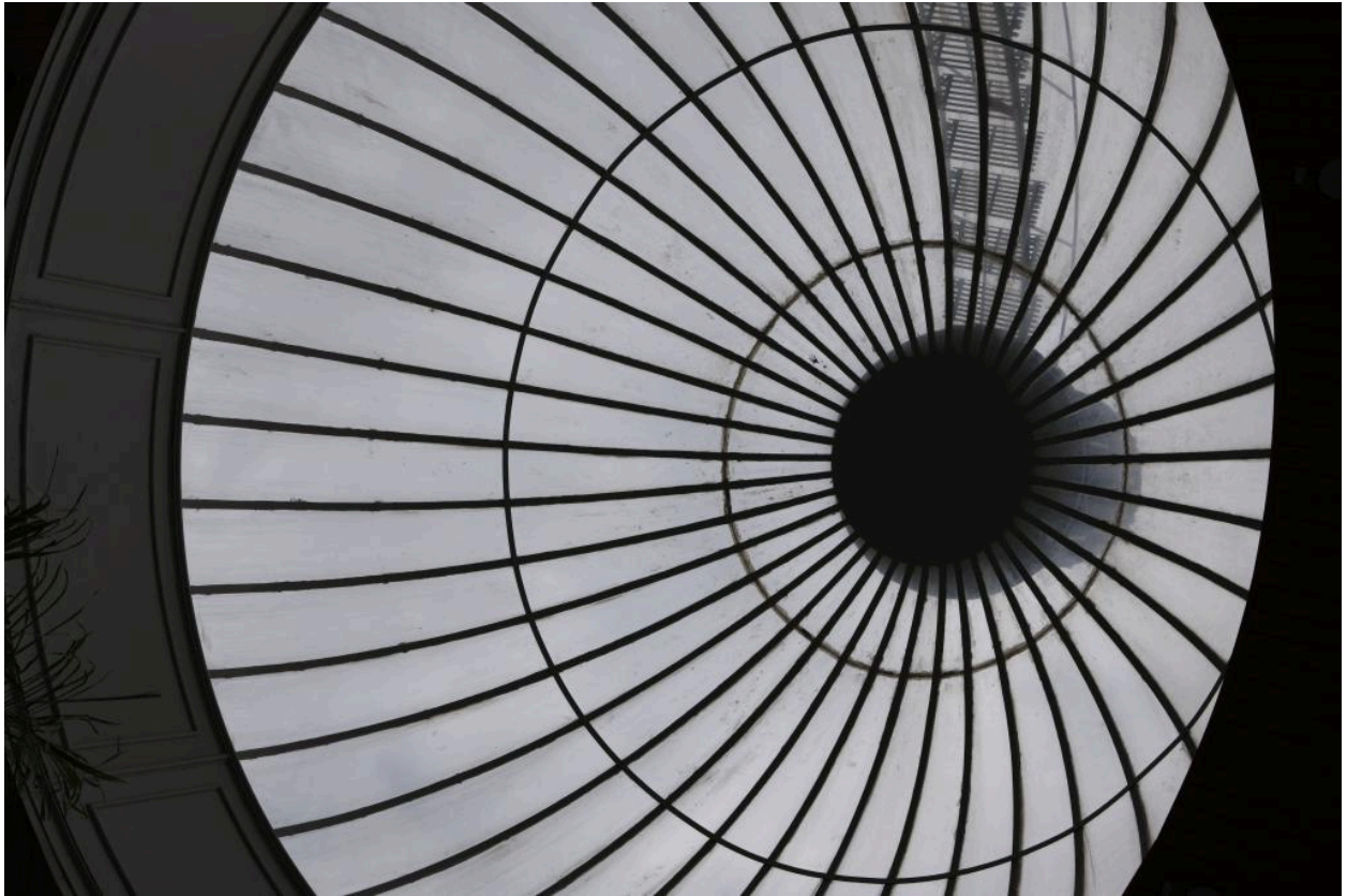
Vue intérieure de la coupole.
