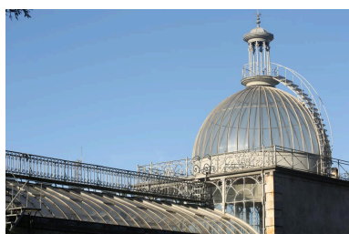
Vue partielle des couvrements de la serre. Phot. Philippe Poitou IVR73_20156551077NUCA
