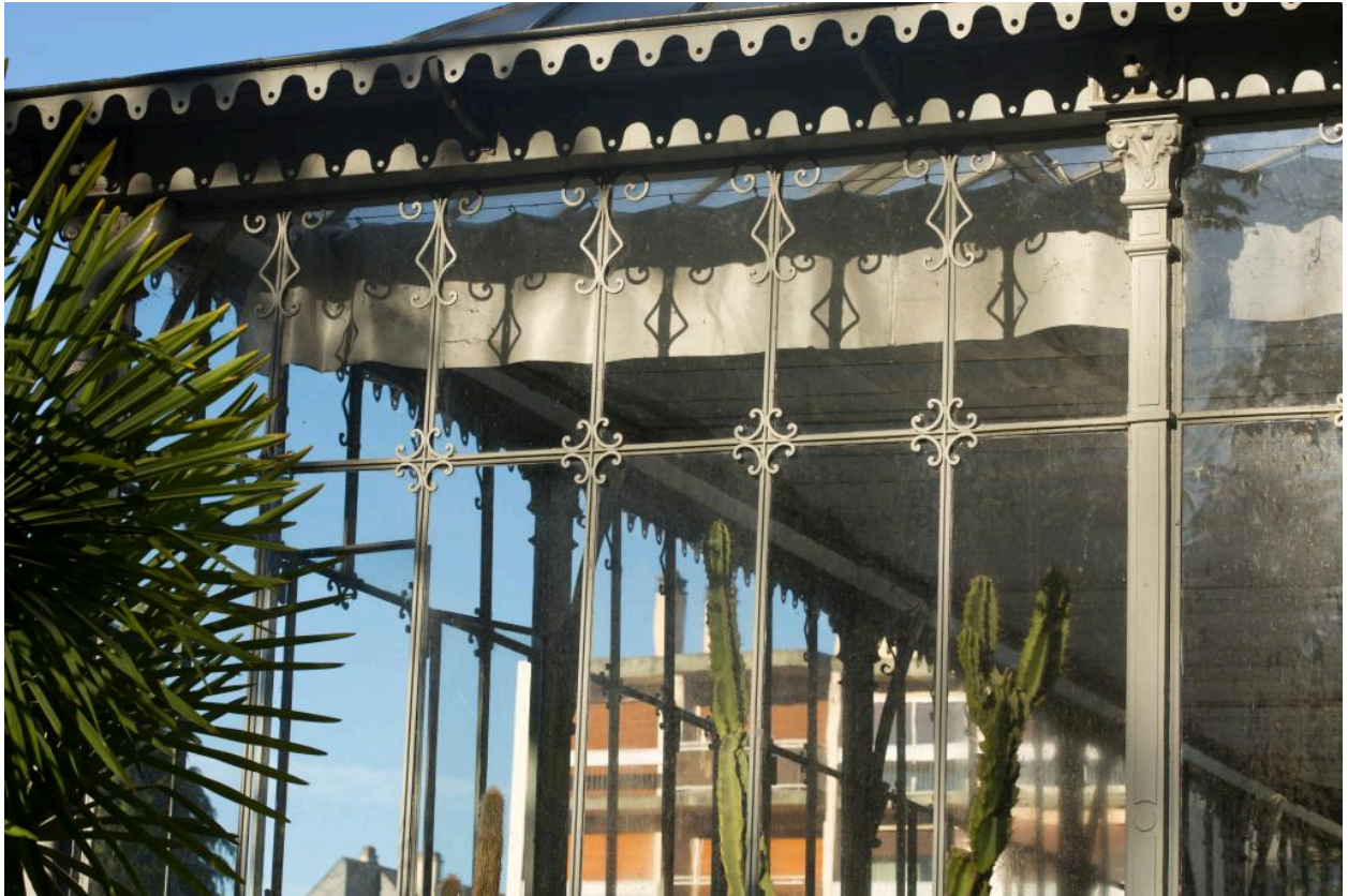
Profilé de l'armature métallique de la serre : détail.
