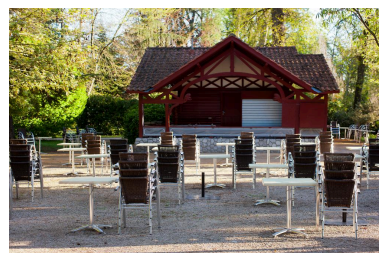
Vue d'ensemble. Phot. Philippe Poitou IVR73_20156551032NUCA
