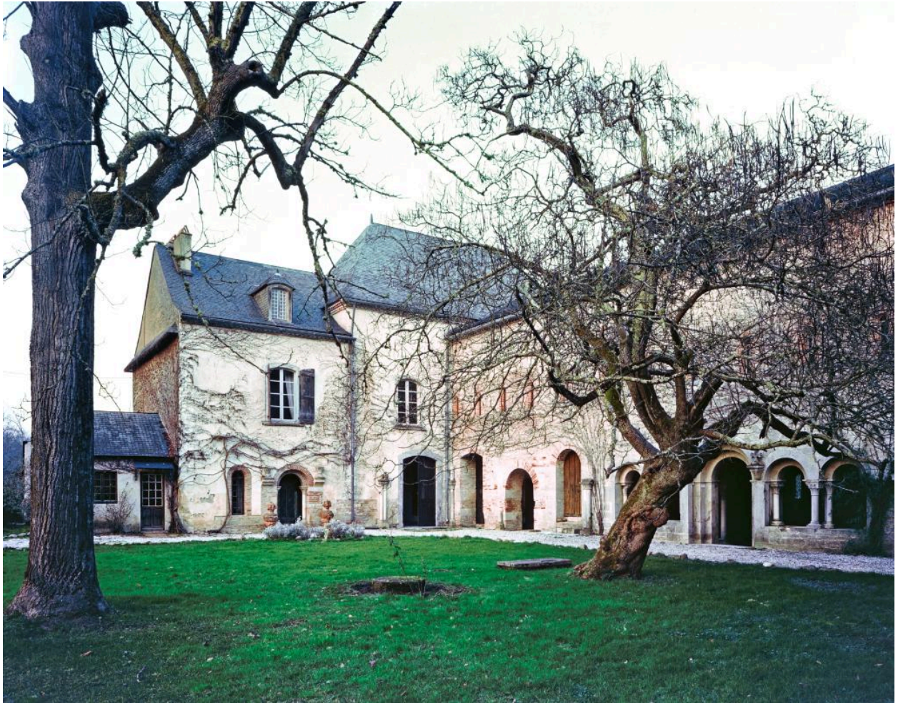
Corps de logis et salle capitulaire : vue d'ensemble (élévation occidentale).
