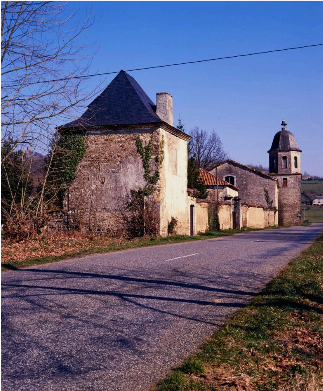
Vue d'ensemble : élévation latérale sud.
