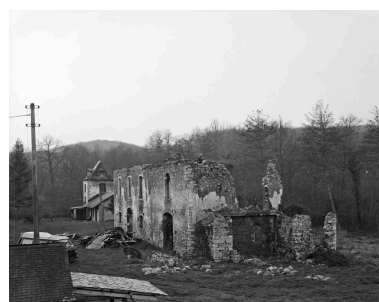
Aile des convers (vue d'angle). Phot. Christian Soula IVR73_19886500013V
