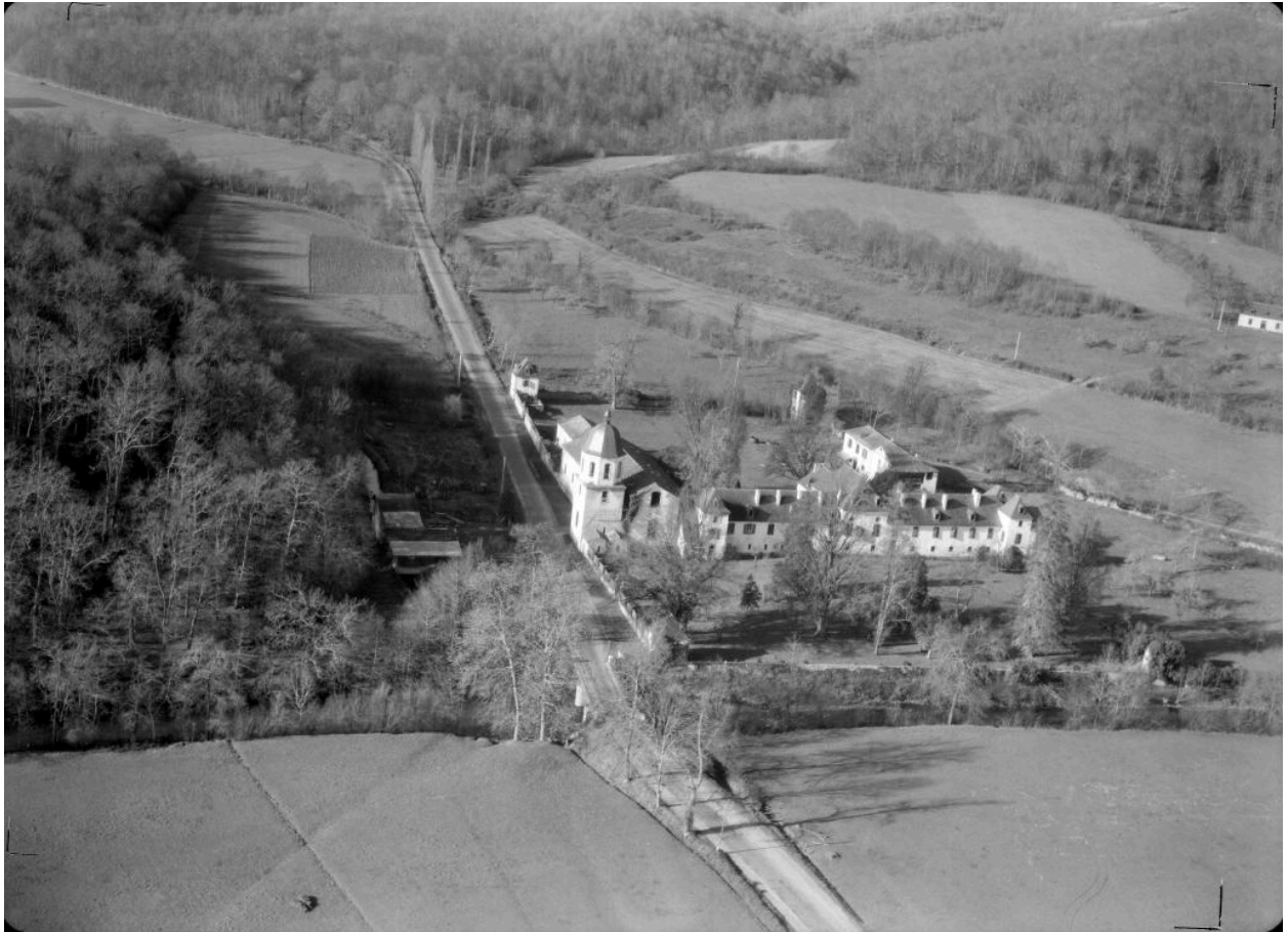
Photographie aérienne : élévation antérieure.
