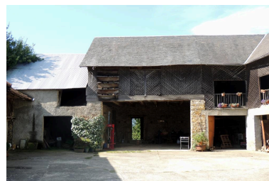
Vue des dépendances vers le sud. Phot. Marion Fourcayran IVD65_20146500492NUCA
