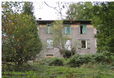
Vue de l'élévation principale depuis le nord. Phot. Marion Fourcayran IVD65_20146500386NUCA
