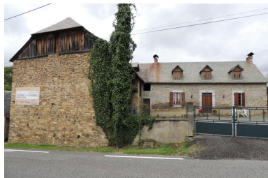
Vue générale de l'ancienne ferme. Phot. Thibaut de Rouvray IVD65_20146500662NUCA
