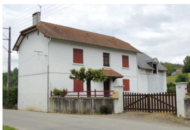
Vue de l'élévation sud. Phot. Marion Fourcayran IVD65_20136500228NUCA
