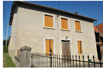
Vue de l'élévation principale depuis l'est. Phot. Marion Fourcayran IVD65_20146500402NUCA
