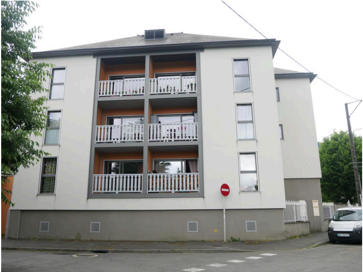
Bâtiment édifié à l'emplacement des Bains du Grand Pré
