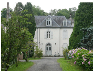
Villa édifiée à l'emplacement des Bains Pierra. Façade principale Phot. Delpech Viviane IVR76_20206509558NUCA
