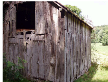
Vue de l'élévation est de la grange. Phot. Camille Ducasse IVD65_20116500005NUCA
