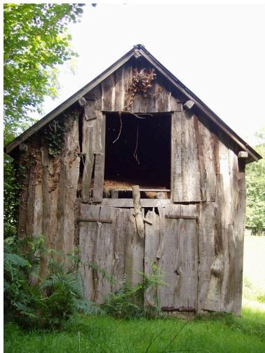
Vue de l'élévation est de la grange. Phot. Camille Ducasse IVD65_20116500004NUCA
