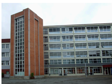
Vue partielle de l'élévation est de la cour. Phot. Roland Chabbert IVR73_20104605890NUCA
