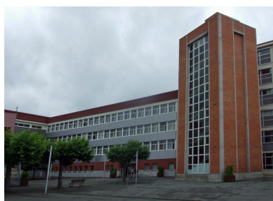
Vue d'ensemble de la cour depuis le nord-est. Phot. Roland Chabbert IVR73_20104605891NUCA
