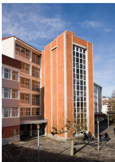
Détail de la tour d'escalier hors oeuvre contre l'élévation est de la cour. Phot. Philippe Poitou IVR73_20114650136NUCA
