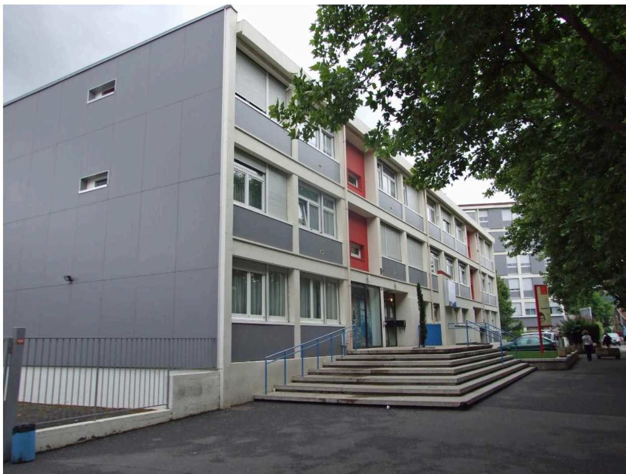
Vue de la façade du bâtiment d'entrée depuis la rue.
