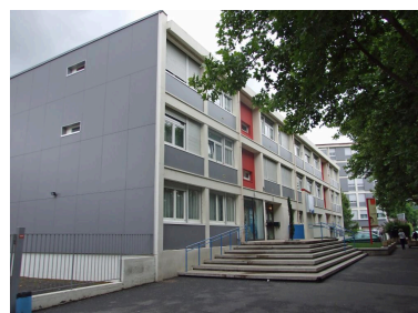
Vue de la façade du bâtiment d'entrée depuis la rue. Phot. Roland Chabbert IVR73_20104605889NUCA
